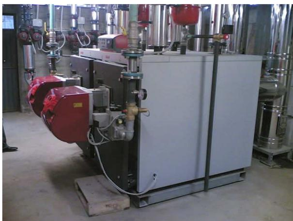
**Figura 2 – Nuova caldaia a condensazione installata presso la scuola primaria “San Giovanni Bosco”.**
